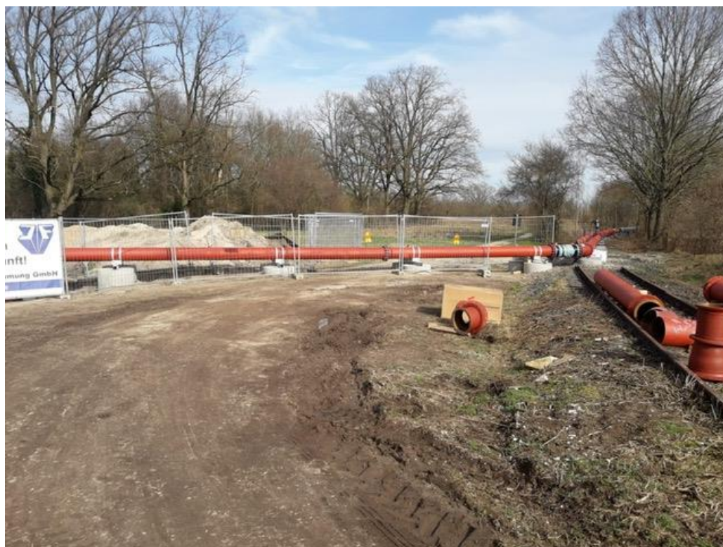
Mit Druckleitung überbauter Wanderweg
