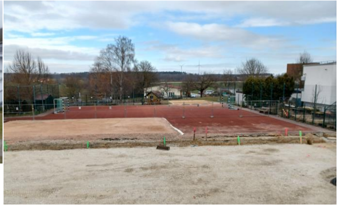
Abbruch der Teilfläche für die Raummodulanlage
