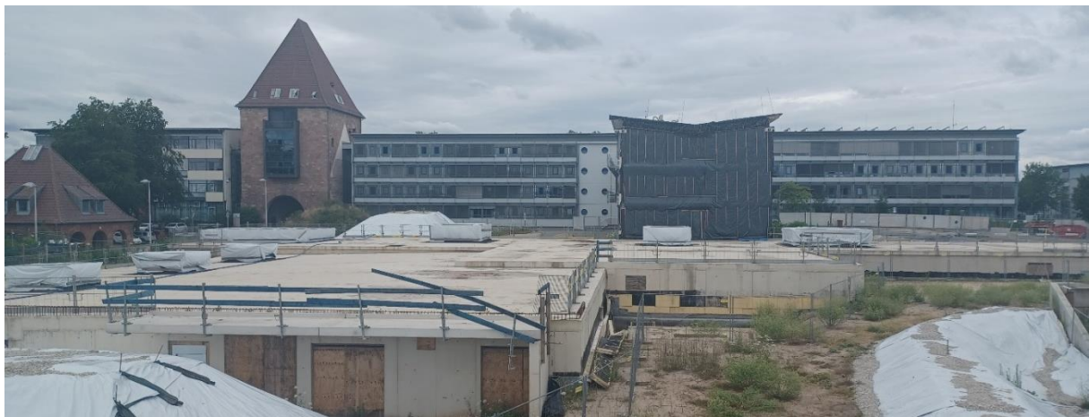
Tiefgarage und Kellerspange unter ehemaligem Erweiterungsbau mit Abbruchkante Bauteil 4
