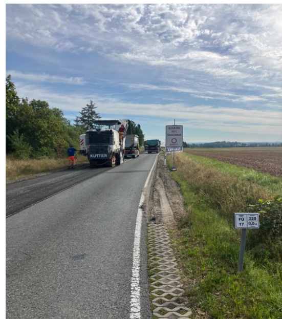
Foto Beginn der Fräsarbeiten
